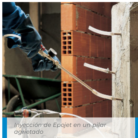
Fijación de los inyectores con Adesilex PG1
