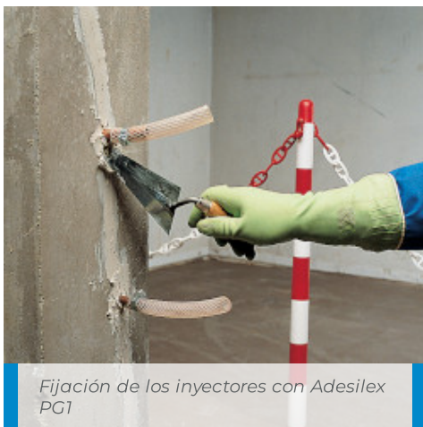
Inyección de Epojet en un pilar agrietado
