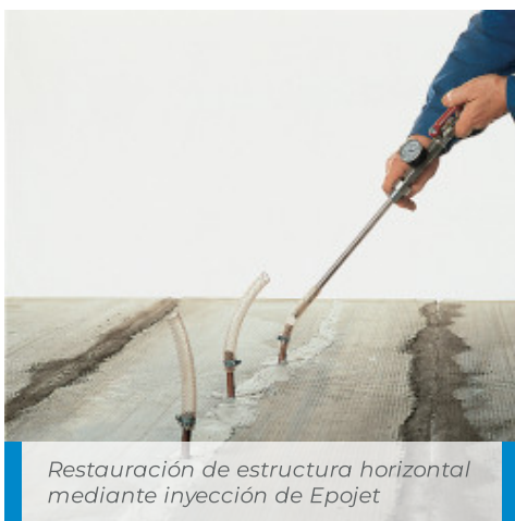
Fijación de los inyectores con Adesilex PG1
