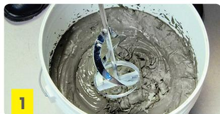
Colocar agua limpia en el balde, luego agregar **weber superflex** paulatinamente (6 Litros por bolsa aproximadamente), mezclar manualmente o con Batidor eléctrico (500 rpm) hasta obtener una pasta homogénea. Dejar reposar 5 minutos.
