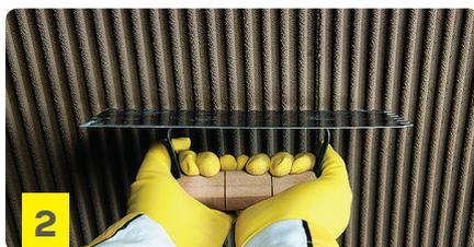
Extender sobre el soporte en paños pequeños de 1m<sup>2</sup> aprox. peinando con una llana dentada para regularizar el espesor y proceder a la colocación. Si fuera necesario, aplicar una capa de mezcla sobre la pieza con la parte lisa de la llana.
